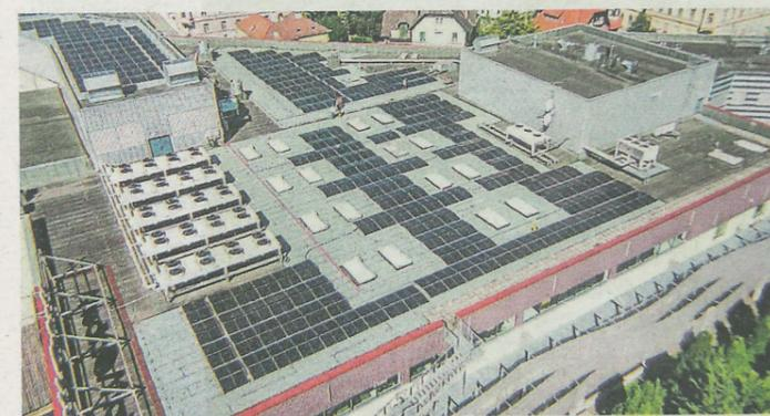
Die Anlage auf dem Dach des Leobener Einkaufszentrums umfasst insgesamt knapp 2500 Quadratmeter Modulfläche, in etwa die Hälfte davon ist auf diesem Bild zu sehen. Foto: LCS
